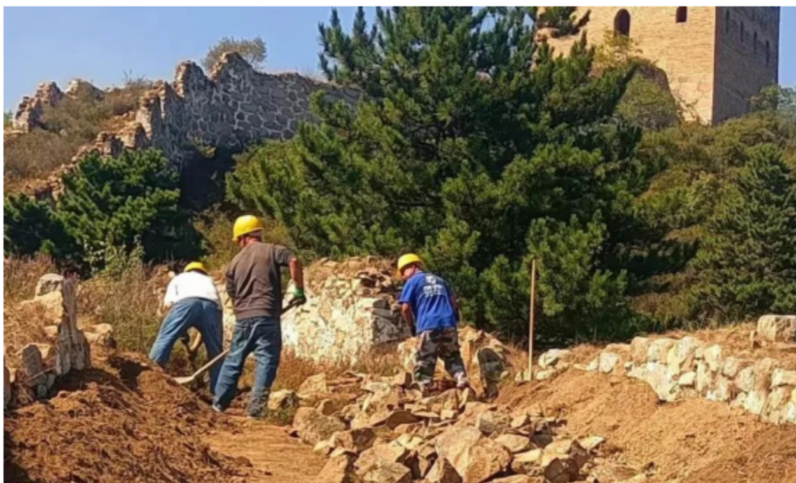
图为：吕景峰老师参加2022年10月修缮紫荆关长城工程
